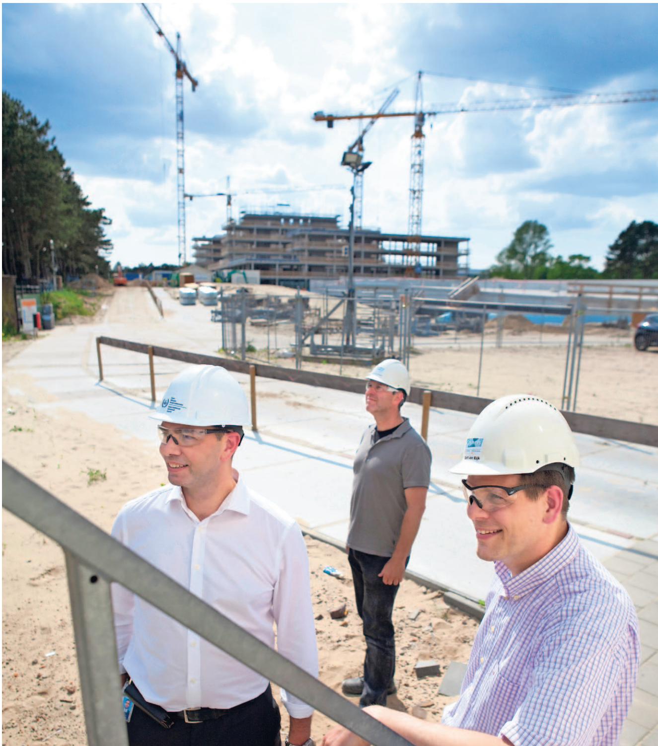
Van links naar rechts projectdirecteur Neil Bradley (ICC), bouwplaatsmanager Pierre van Dongen (Courtys) en projectmanager Bart van Eijk op de bouwplaats. Foto: Suzanne van de Kerk
